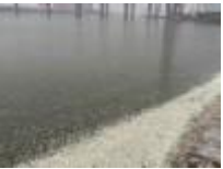
15/15 网友拍摄的渤海海河防潮闸旁的场景。
