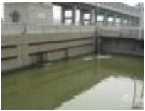
11/15 网友拍摄的渤海海河防潮闸旁的场景。
